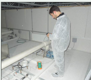
Sensores conectados al instrumento Resonance pasan por el techo de la incubadora
