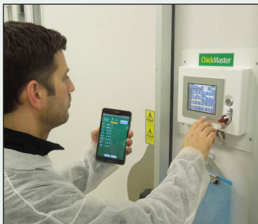
Un dispositivo móvil Android recibe los valores actuales de temperatura y permite al técnico hacer ajustes en la pantalla de control
