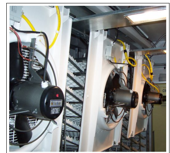
Incubadora Classic con tableros ventiladores plásticos Vostermans en posiciones de funcionamiento y de mantenimiento
