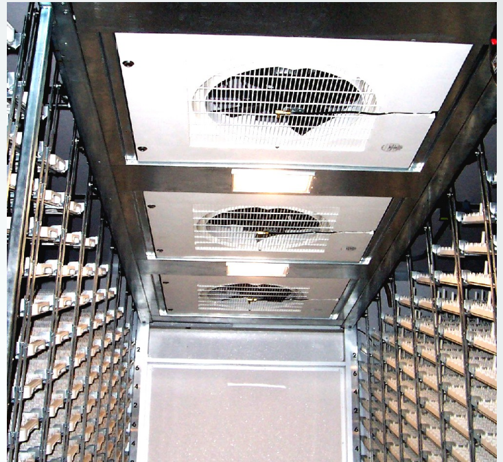
Sistema de iluminación de alta intensidad
